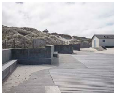
Eksempel på kanter i beton Foto: Skaarup Landskab
