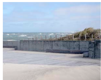
Eksempel på kanter i beton Foto: Skaarup Landskab
